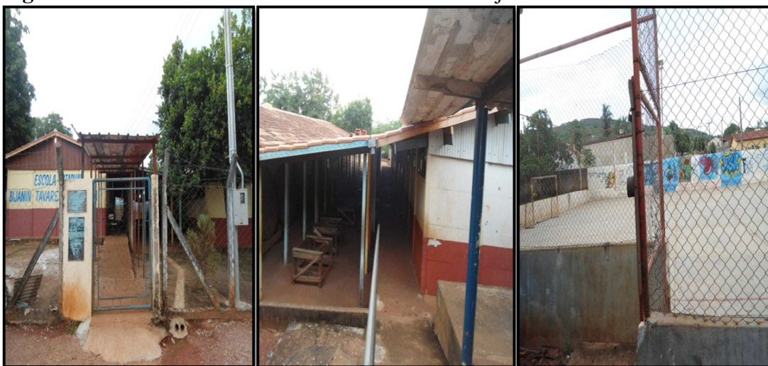
Figura 01: Fase final da reforma na Escola Estadual Bijamin Tavares da Silva.
